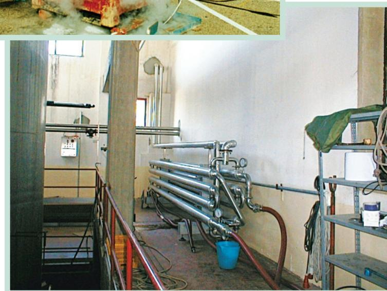
Fig. 65: Equipement technique pour échauffer et refroidir (Echangeur de température tubulaire).
